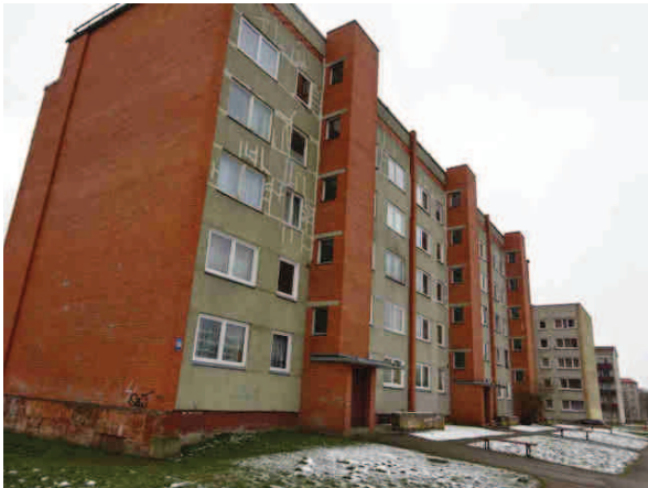
Dzīvojamās ēkas fasādes daļa no ielas
