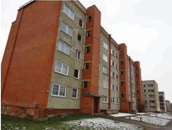
Dzīvojamās ēkas fasādes daļa no ielas
