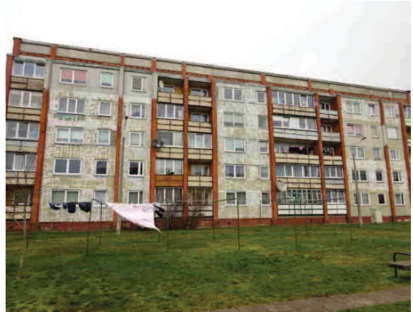
Dzīvojamās ēkas fasādes daļa no pagalma
