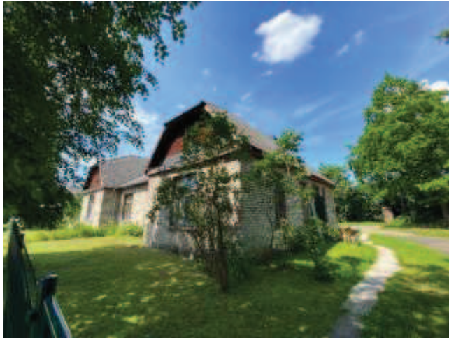
Dzīvojamās ēkas fasādes daļa no Depo ielas
