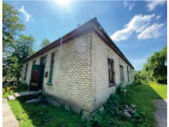
Dzīvojamās ēkas fasādes daļa no pagalma
