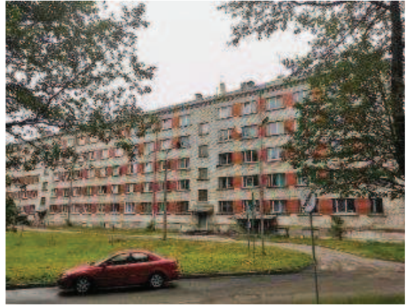
Dzīvojamās ēkas fasādes daļa (pagalma daļa)
