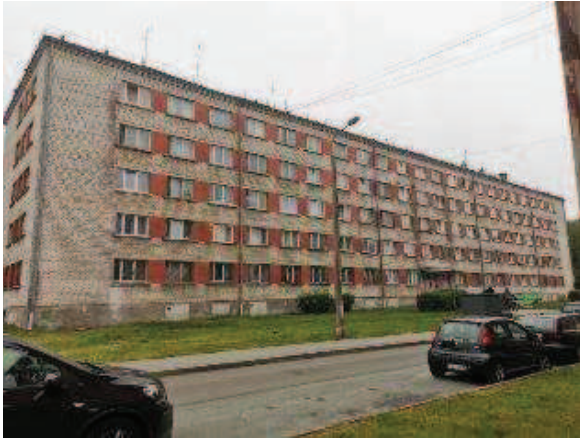
Dzīvojamās ēkas fasādes daļa
