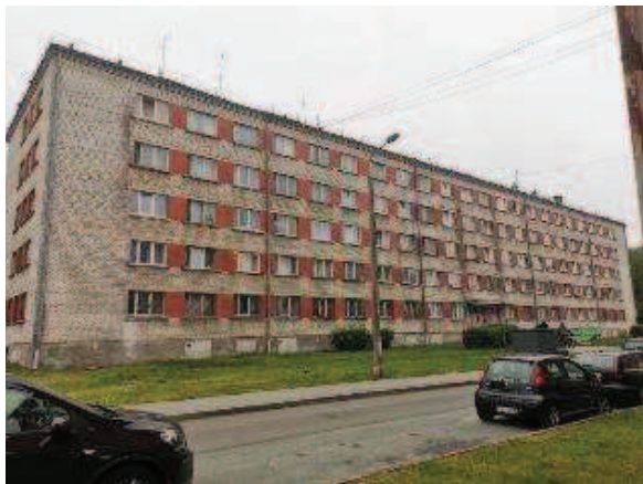
Dzīvojamās ēkas fasādes daļa
