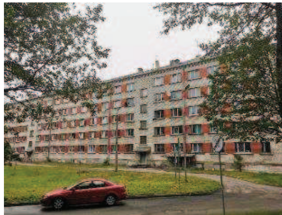
Dzīvojamās ēkas fasādes daļa (pagalma daļa)
