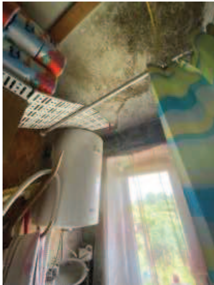
Sanitārtehniskā telpa (telpa Nr. 4)
