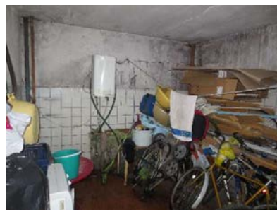
Koplietošanas telpa – sanitārā telpa (dušas)
