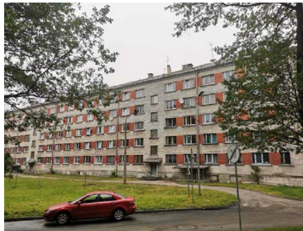
Dzīvojamās ēkas fasādes daļa (pagalma daļa)
