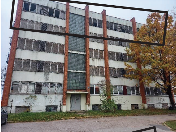
Ēkas fasādes ar dzīvokļa logiem
