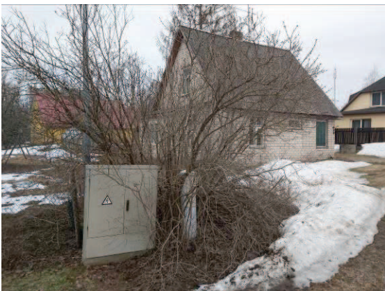
Elektrības sadalnes skapis
