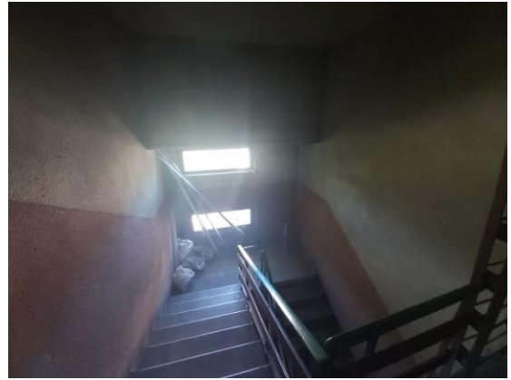
Mājas kāpņu telpa
