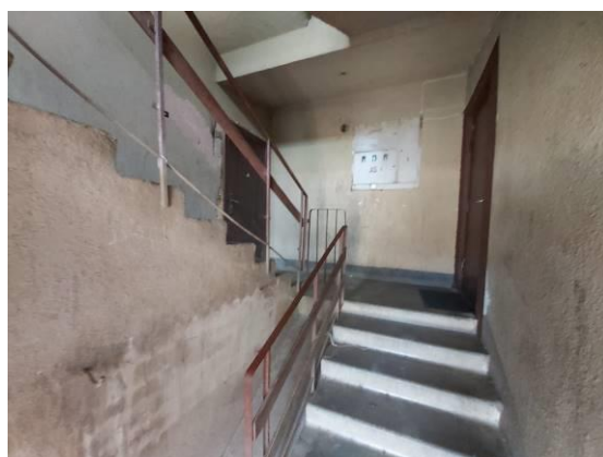
Mājas kāpņu telpa
