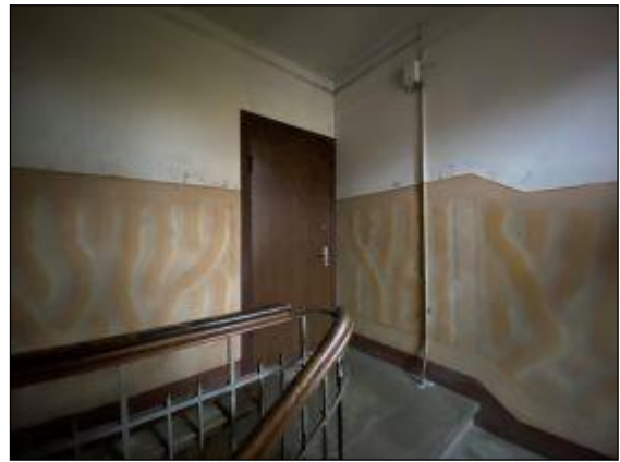
Kāpņu telpa, novērtējamā dzīvokļa durvis
