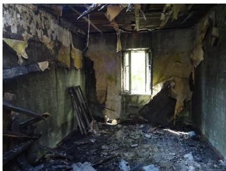
Ēkas 2. stāva iekšskati
