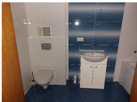
Savienotā sanitārtehniskā telpa (telpa nr.3 plānā)
