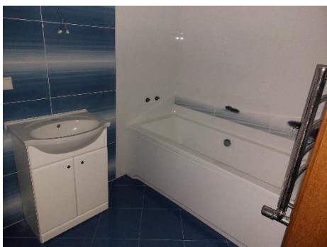
Savienotā sanitārtehniskā telpa (telpa nr.3plānā)
