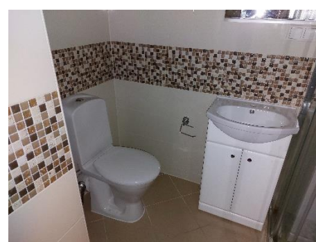
Savienotā sanitārtehniskā telpa (telpa nr.3 plānā)
