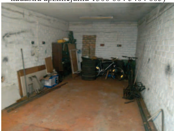
29.attēls. Iekšskats garāžā (nedzīvojamā ēka ar kadastra apzīmējumu 1300 004 5404 005)
