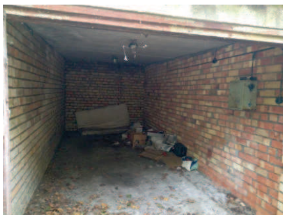
34.attēls. Iekšskats garāžā (nedzīvojamā ēka ar kadastra apzīmējumu 1300 004 5404 004)
