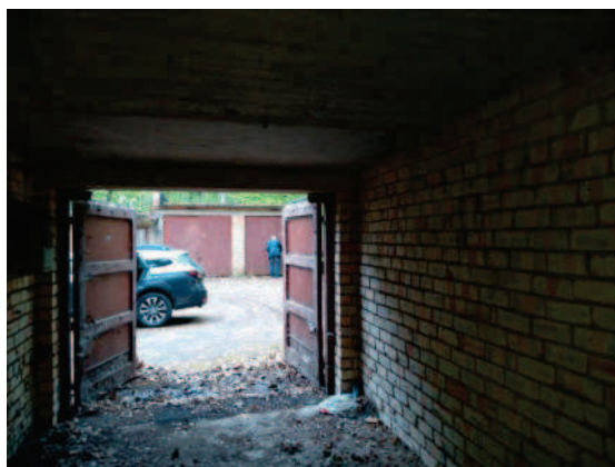
28.attēls. Iekšskats garāžā (nedzīvojamā ēka ar kadastra apzīmējumu 1300 004 5404 005)
