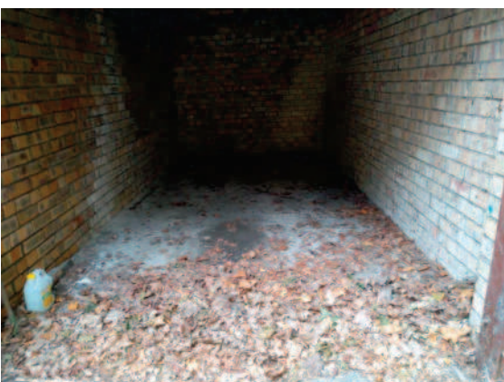
33.attēls. Iekšskats garāžā (nedzīvojamā ēka ar kadastra apzīmējumu 1300 004 5404 004)
