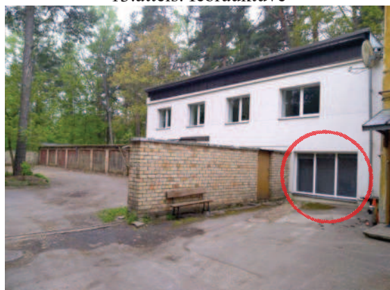
15.attēls. Nedzīvojamā ēka ar kadastra apzīmējumu 1300 004 5404 005 (sarkanajā aplī - pārbūvētā garāža)
