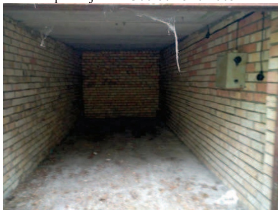
26.attēls. Iekšskats garāžā (nedzīvojamā ēka ar kadastra apzīmējumu 1300 004 5404 005)
