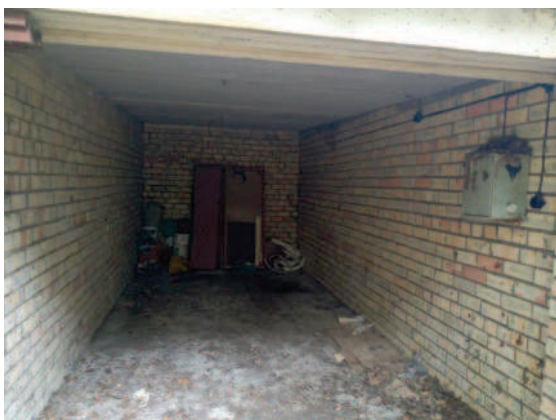
27.attēls. Iekšskats garāžā (nedzīvojamā ēka ar kadastra apzīmējumu 1300 004 5404 005)
