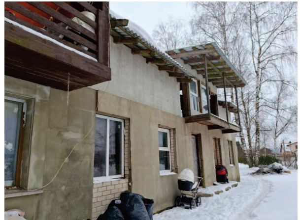
Būvniecības stadijā esošā ēkas daļa
