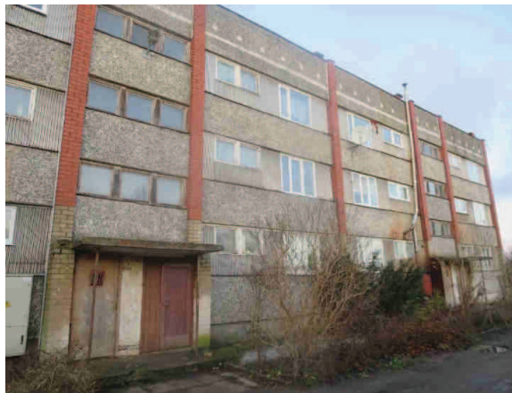
Dzīvojamās ēkas fasādes daļa
