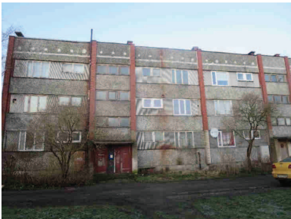
Dzīvojamās ēkas fasādes daļa
