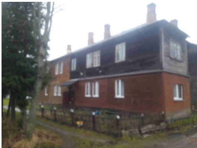
Dzīvojamās ēkas fasādes no iekšpagalma puses
