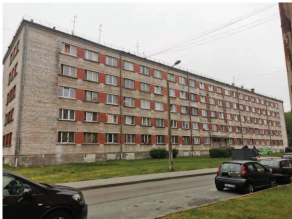
Dzīvojamās ēkas fasādes daļa
