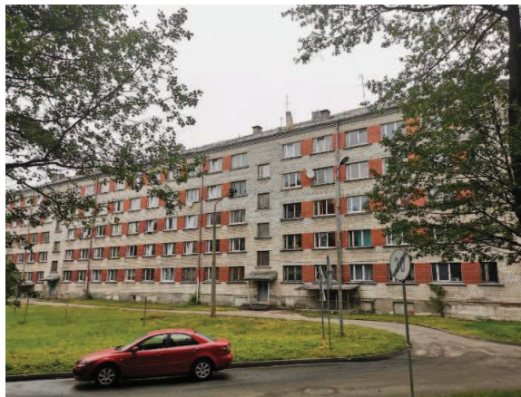
Dzīvojamās ēkas fasādes daļa (pagalma daļa)
