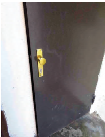
Kāpņu telpas slēdzamās durvis
